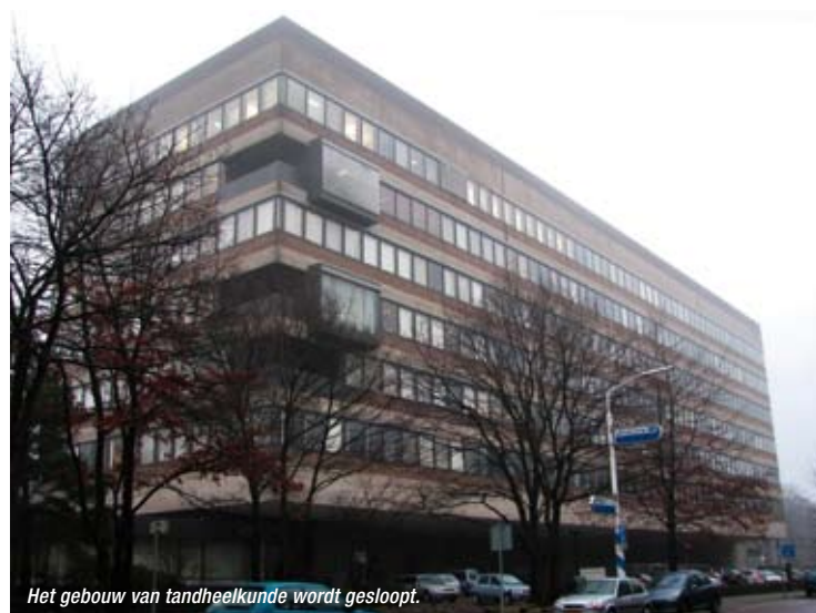
Het gebouw van tandheelkunde wordt gesloopt.
